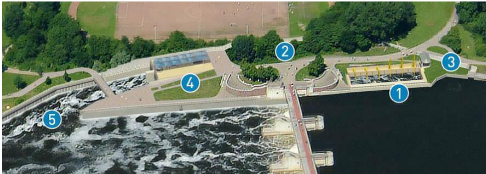
Figuur 7. WKC te Bremen (1. Inlaat; 2. inlaatkanaal; 3. vispassage, 4. WKC; 5. Uitlaatkanaal).
